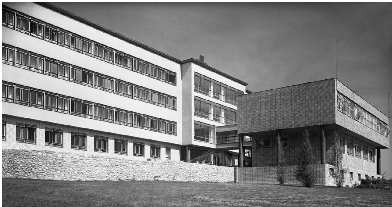
Okresní nemocnice v Kyjově, 1938–48, hlavní budova.
