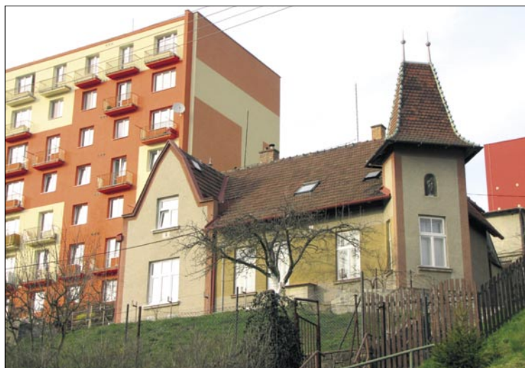
VIII. Adamov, sousedství tradicionalistické vilky s purizovanou fasádou a bytového panelového domu. Foto: Martin Horáček.
