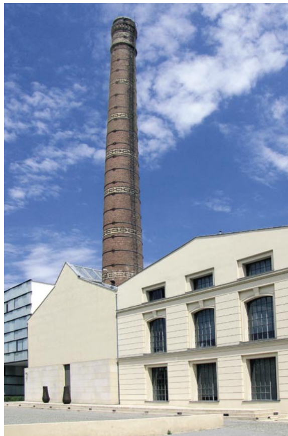
Claudio Silvestrin – Lorenzo Parilli – Oliver Kampshoff, Kotelna, administrativní budova vzniklá přestavbou kotelny, Praha-Karlín, 2004. Vlevo Carlo Baumschlager – Dietmar Eberle / Baumschlager Eberle, Cornlofts Šaldova, bytový dům vzniklý přestavbou a dostavbou sýpky, 2005–2009.
