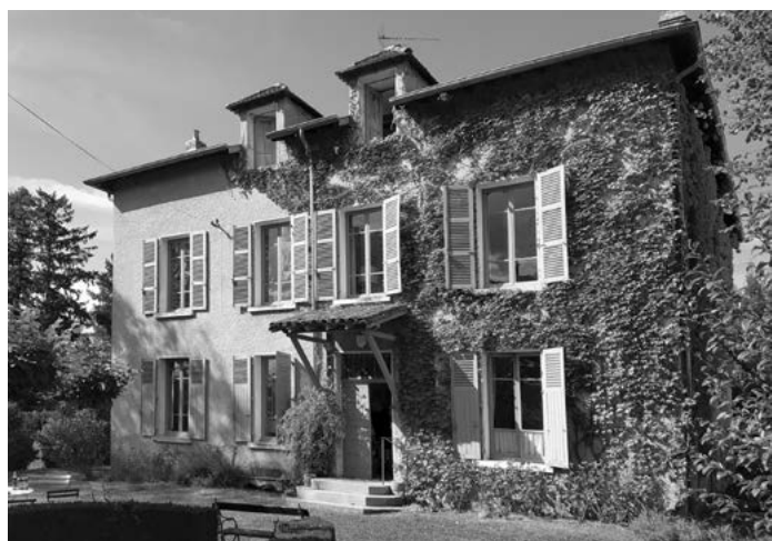
Pourratův dům s pracovnou v Ambertu.
