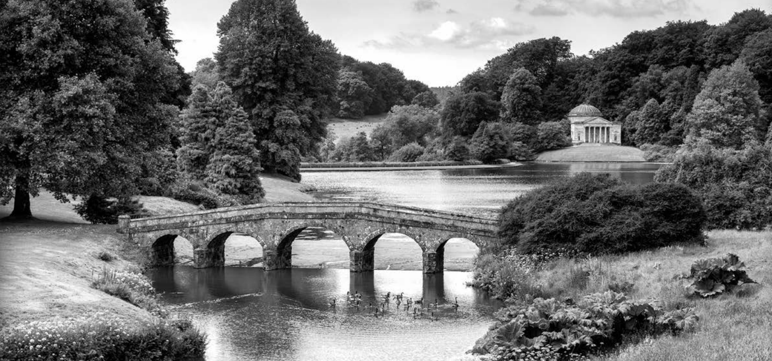
Stourhead Palladian Bridge. Foto: Wikimedia Commons
