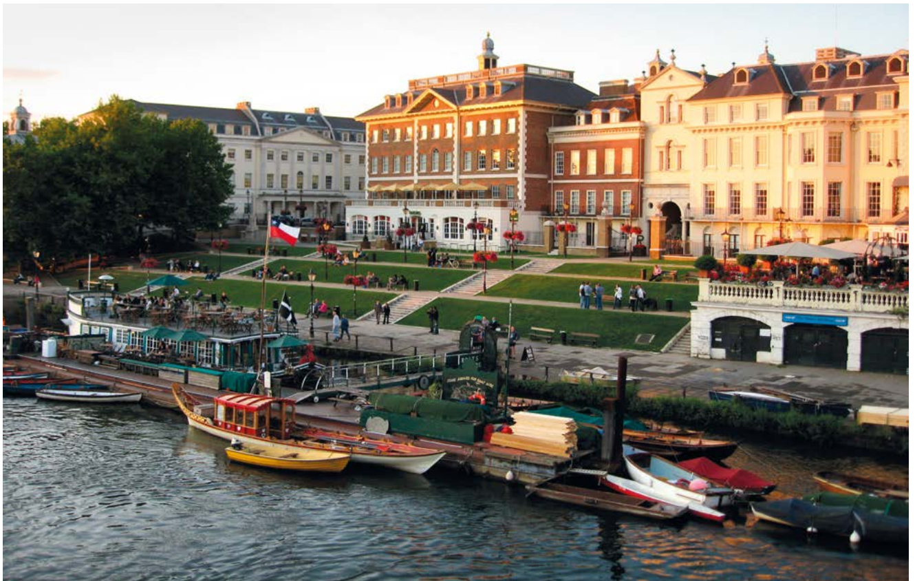
2. „Duch místa“ proti „duchu doby“: Quinlan Terry, Richmond Riverside, Velký Londýn, 1984-1987. Foto: Martin Horáček, 2008
