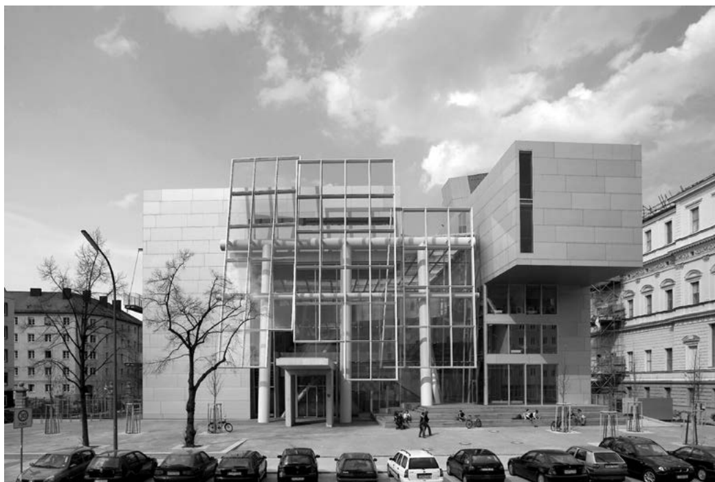
5. Coop Himmelblau: Akademie výtvarných umění v Mnichově. Foto: https:// coop-himmelblau.at
